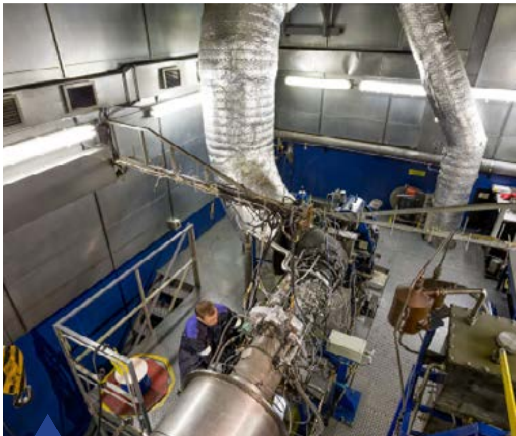
Испытательный стенд №15 после модернизации
